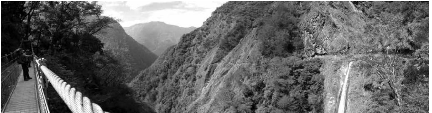
八通関古道の吊橋から雲龍瀑布を望む
